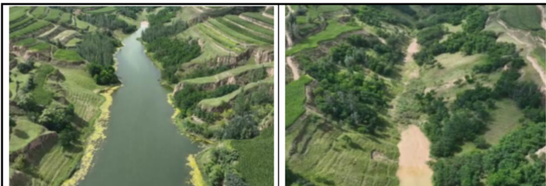
南沟沟道现状照片（拍摄于2024年8月）
