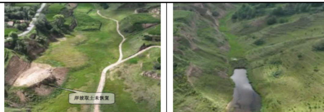
老张沟沟道现状照片（拍摄于2024年8月）
