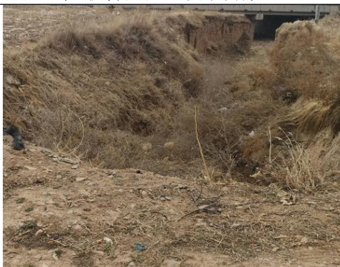
光联村庙沟淤地坝下游沟道
