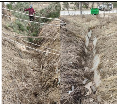
光联村东沟淤地坝下游渠道
