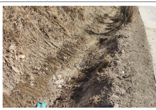
大碱沟淤地坝下游渠道
