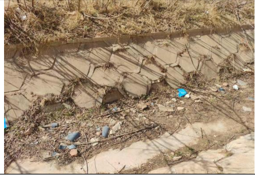
城关镇工业园区北侧渠道
