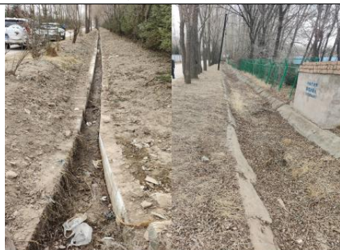
光联村西淤地坝下游渠道
