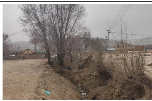
光联村水洞淤地坝下游沟道
