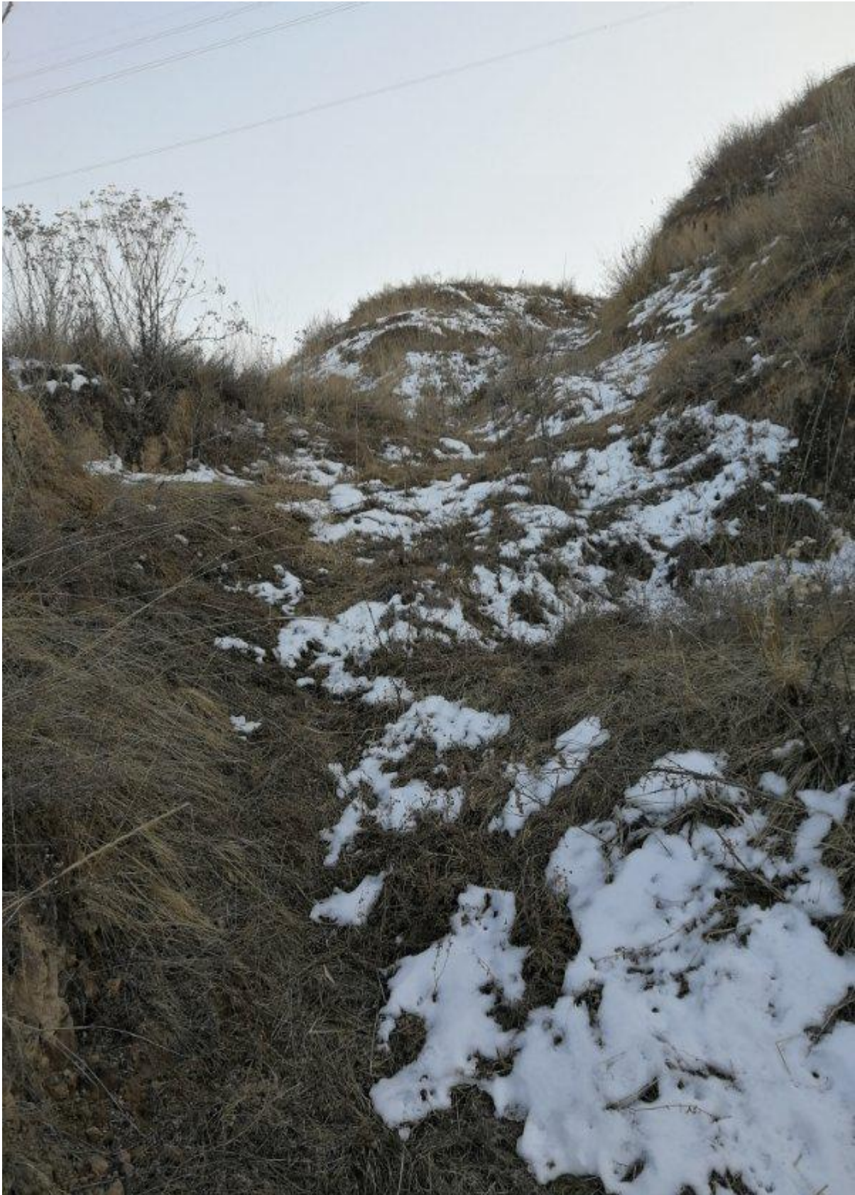
项目区现状图片 3-3
